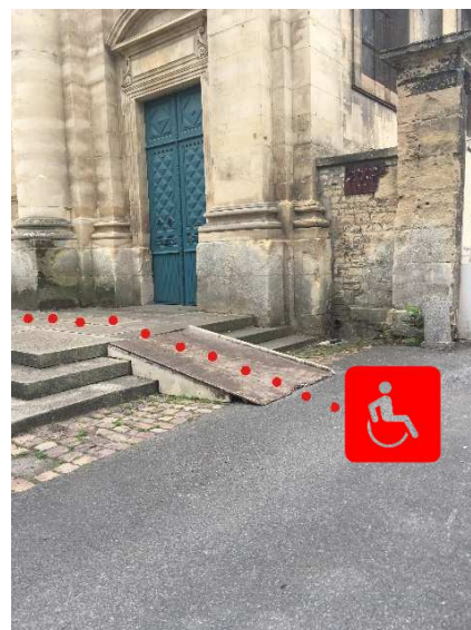
Rampe d'accès à droite de l'église
