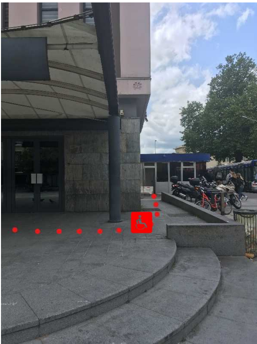
Rampe d'accès Côté Cour (boulevard Maréchal-Leclerc) :
