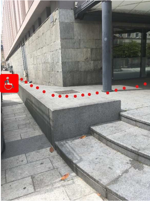
Rampe d'accès Côté Jardin (rue de l'Oratoire) :
